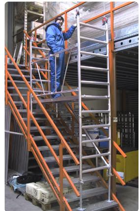
**OBS:** Opstilles rullestillads i specialopstilliner, hvor hjul erstattes af fodplader og stilladset forankres, ændres stilladstypen fra "Rullestillads" til "Facadestillads".
